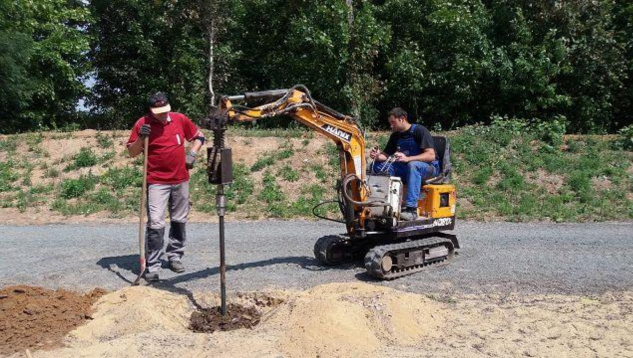
Das Bohren der Löscher für die Fundamente der Ballfangzäune gestaltete sich auf Grund der Bodenverhältnisse schwierig. Verschiedene Technik kam zum Einsatz.
