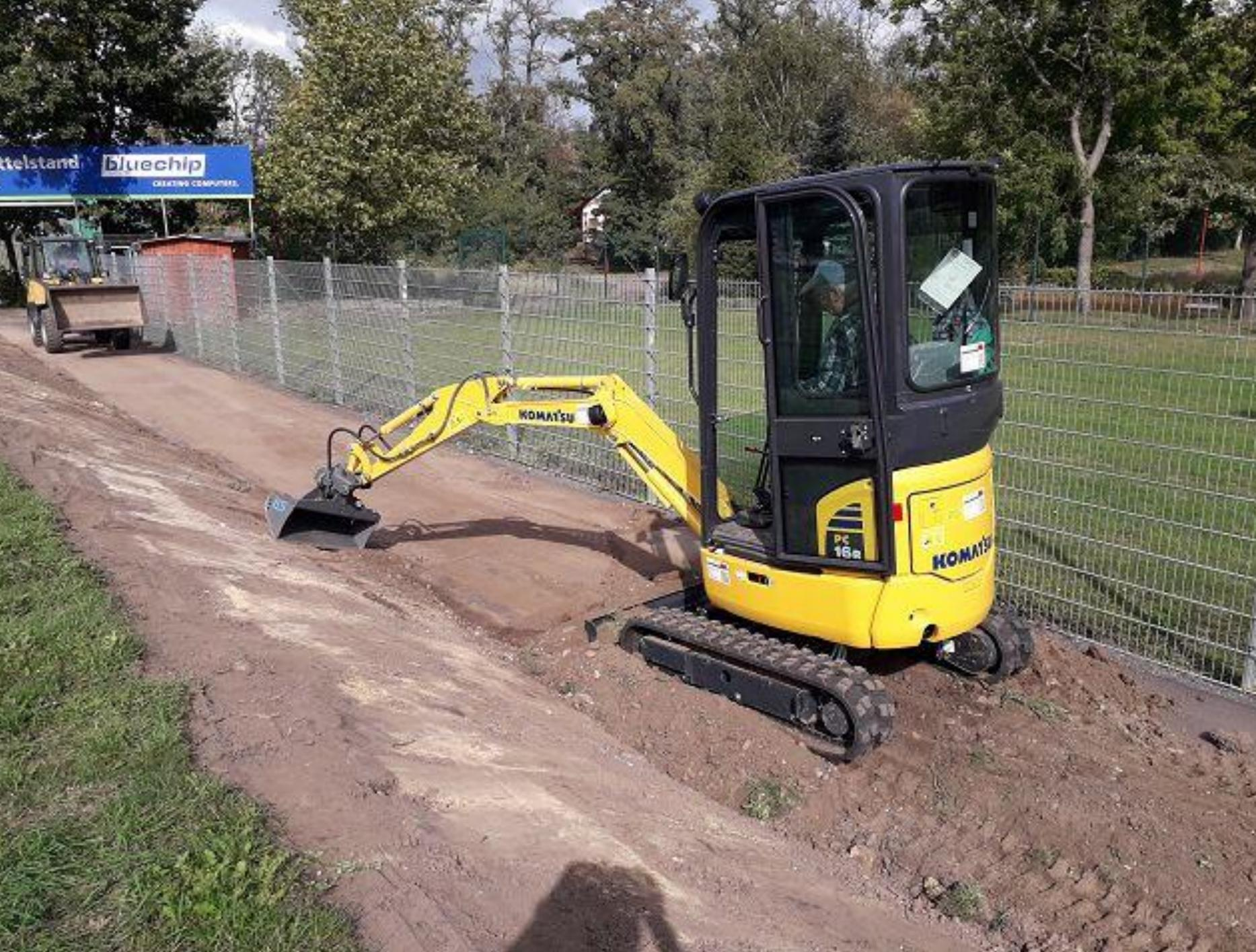
Der Damm am Zugang zum Platz IV erhält einen flacheren Böschungswinkel.
