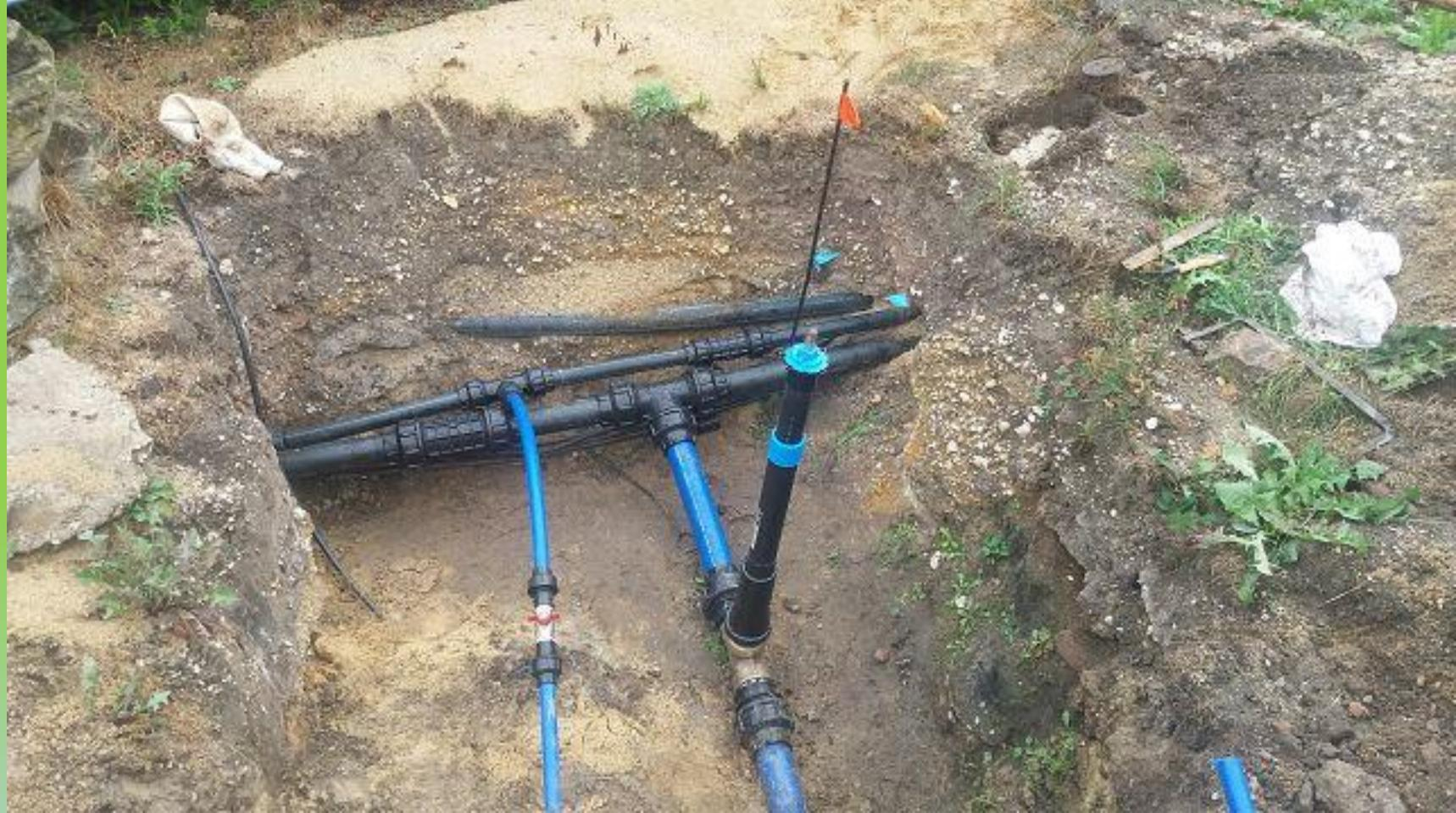
Einbinden der Beregnung für den Platz IV in die vorhandene Anlage.
