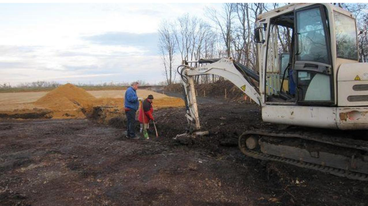
Die Gräben für die Beregnungsanlage sind mit Sand verfüllt wurden.
