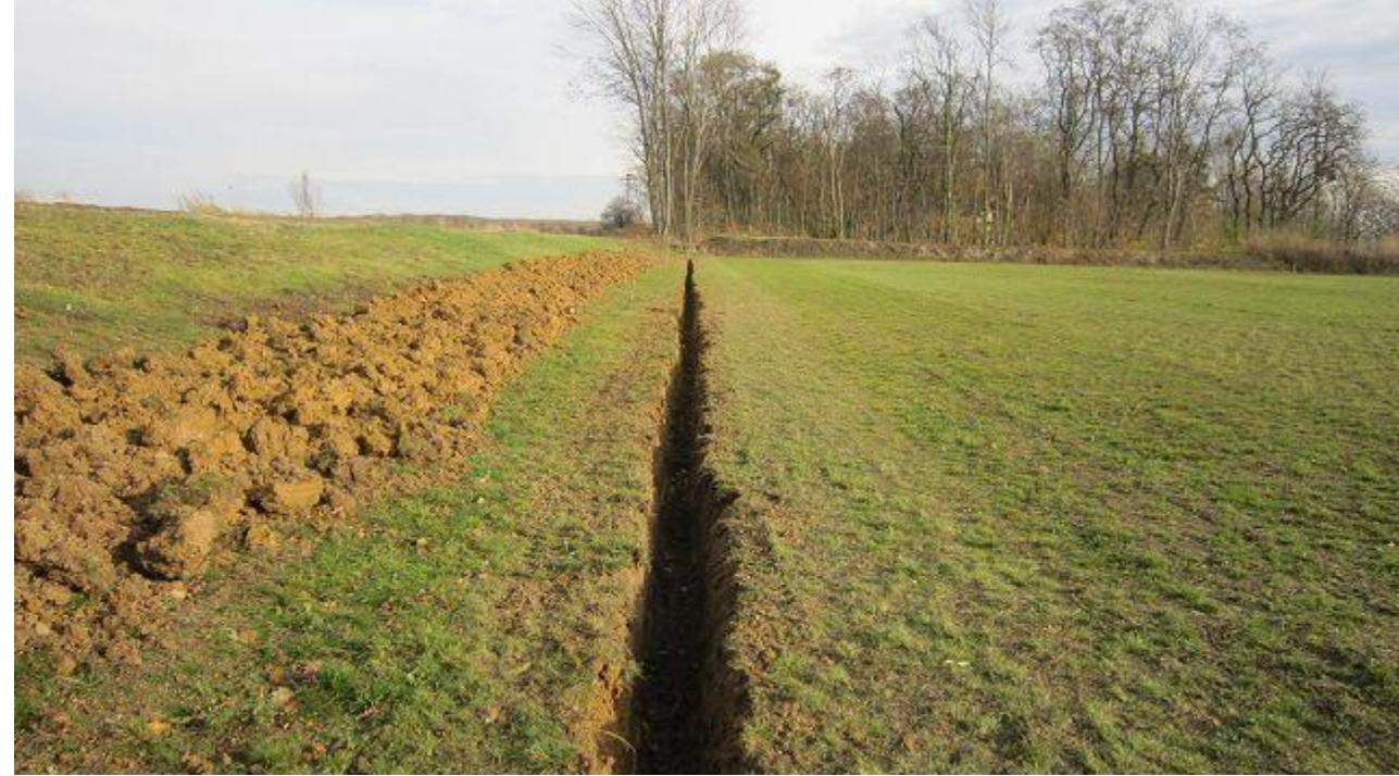
Ein Minibagger war das geeignete Gerät zur Erstellung der Gräben.
