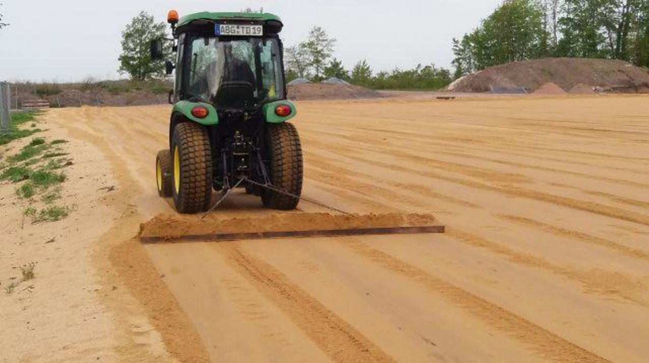
Ein Traktor mit Schleppschiene beseitigt die Reifenspuren des Graders.
