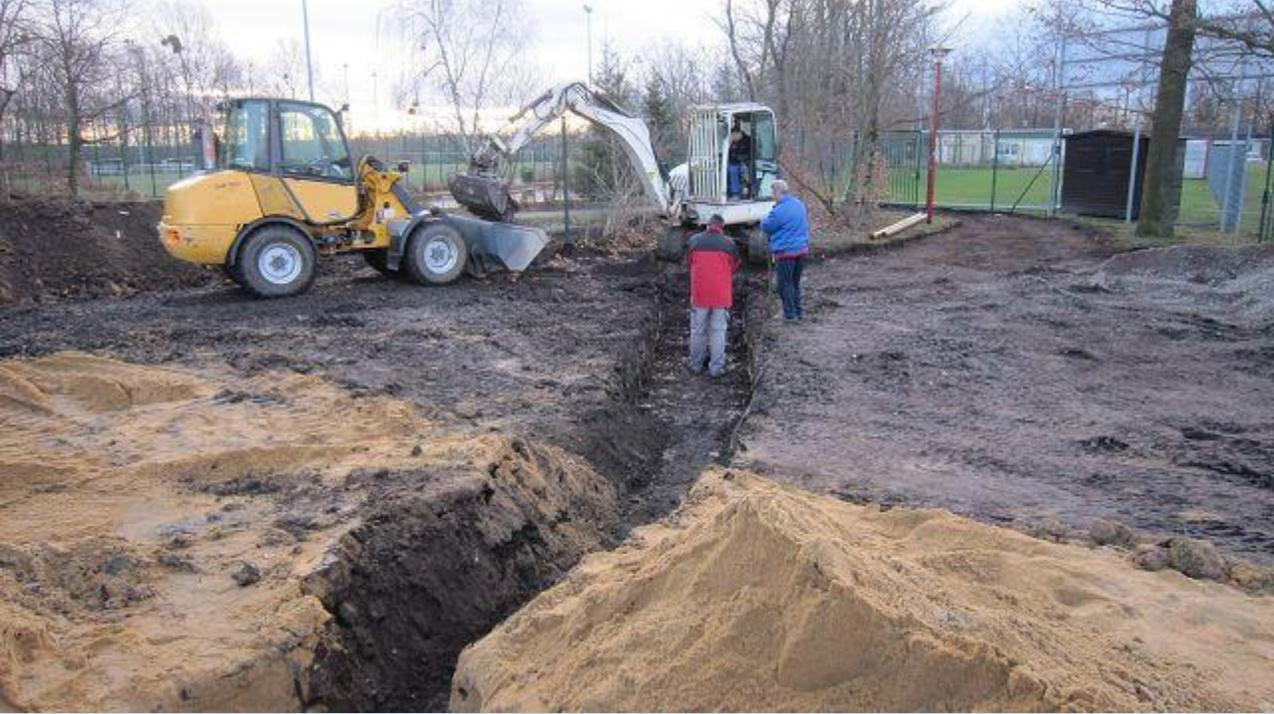
Die Wasserleitung und Steuerkabel der Beregnungsanlage werden Richtung Teich verlegt.
