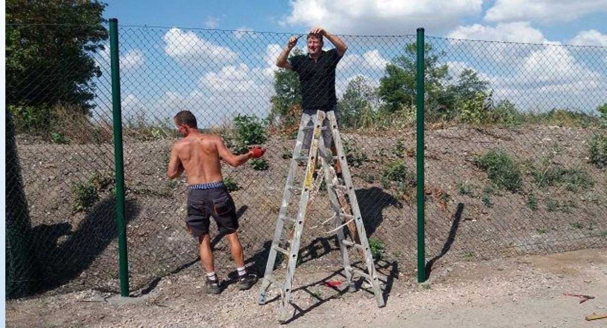
Rund um den Platz IV wird auf einer Länge von 275m ein 2,50m hoher Maschendrahtzaun installiert.
