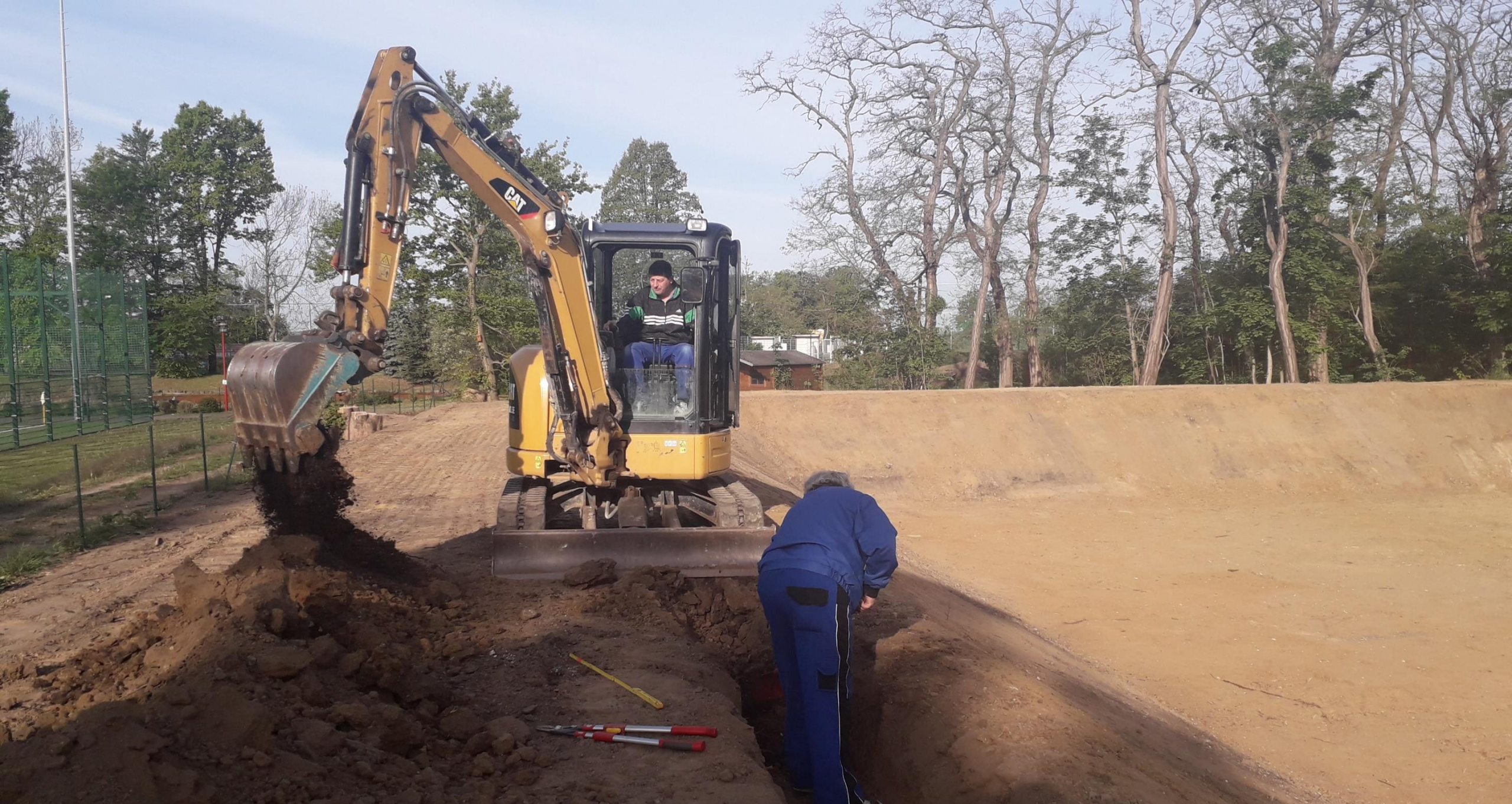
Am Rand der Teiche entsteht ein Graben in dem die Enden der Teichfolie fixiert werden.
