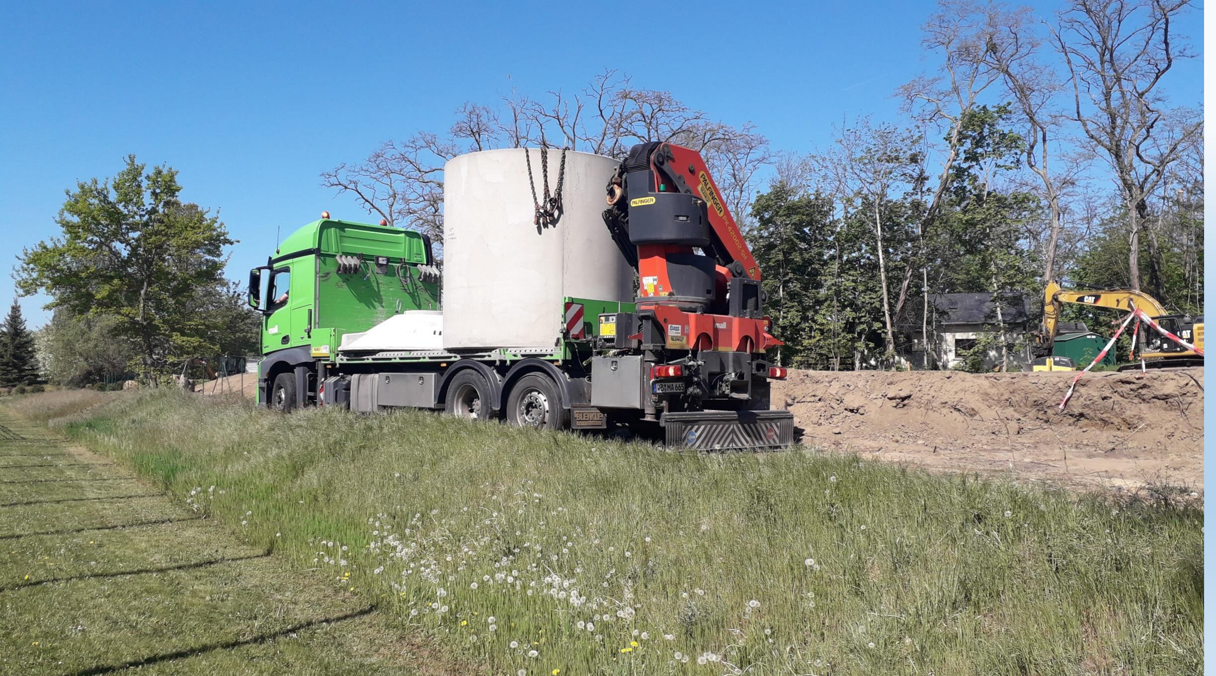
Die Zisterne wird angeliefert. In dieser werden die Zuflüsse aus beiden Teichen münden und die Beregnungspumpe installiert.
