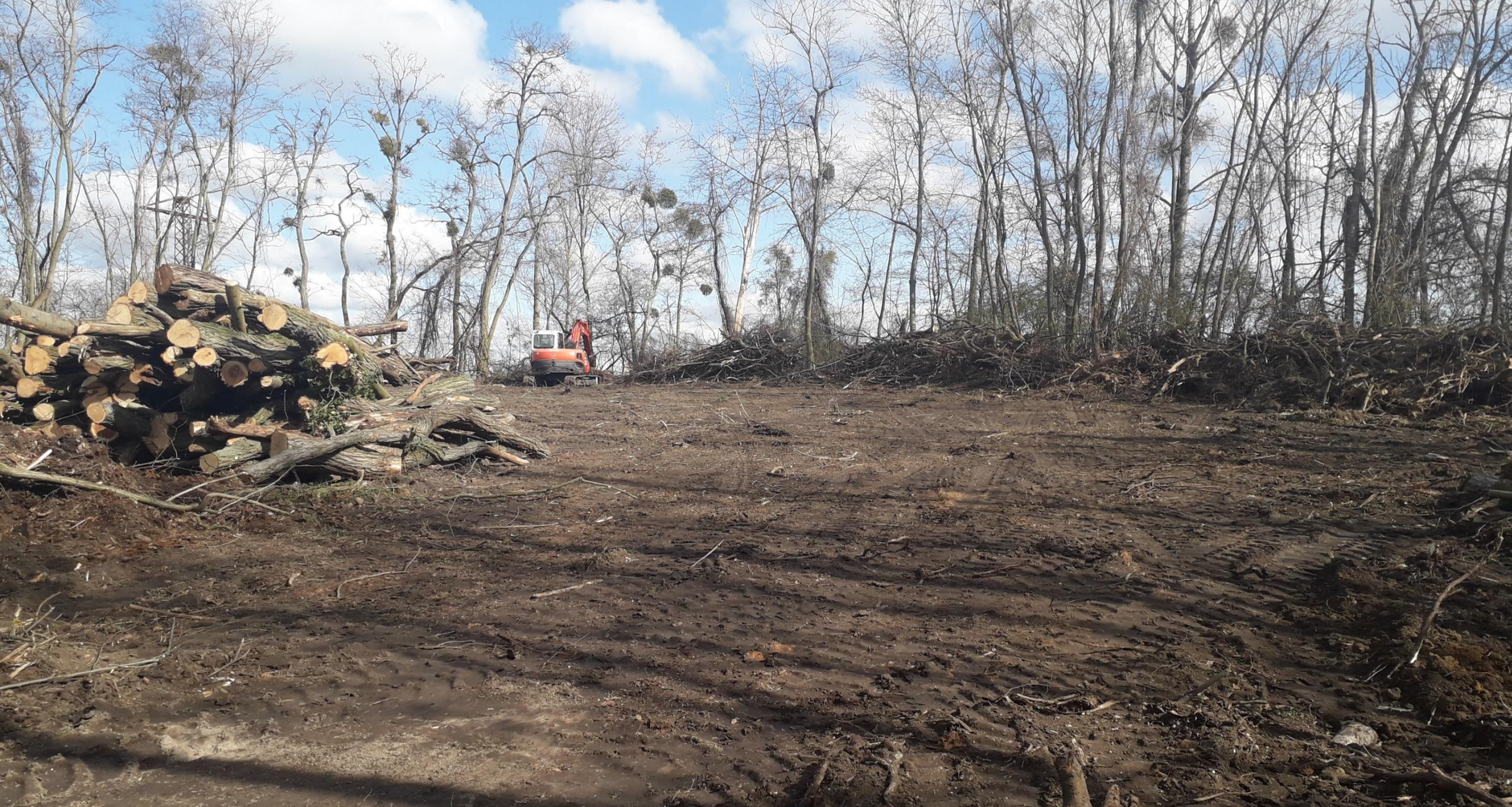
Die brauchbaren Stämme wurden zur weiteren Verwendung gestapelt. Aus den Büchen und Ästen entsteht eine Benjeshecke.
