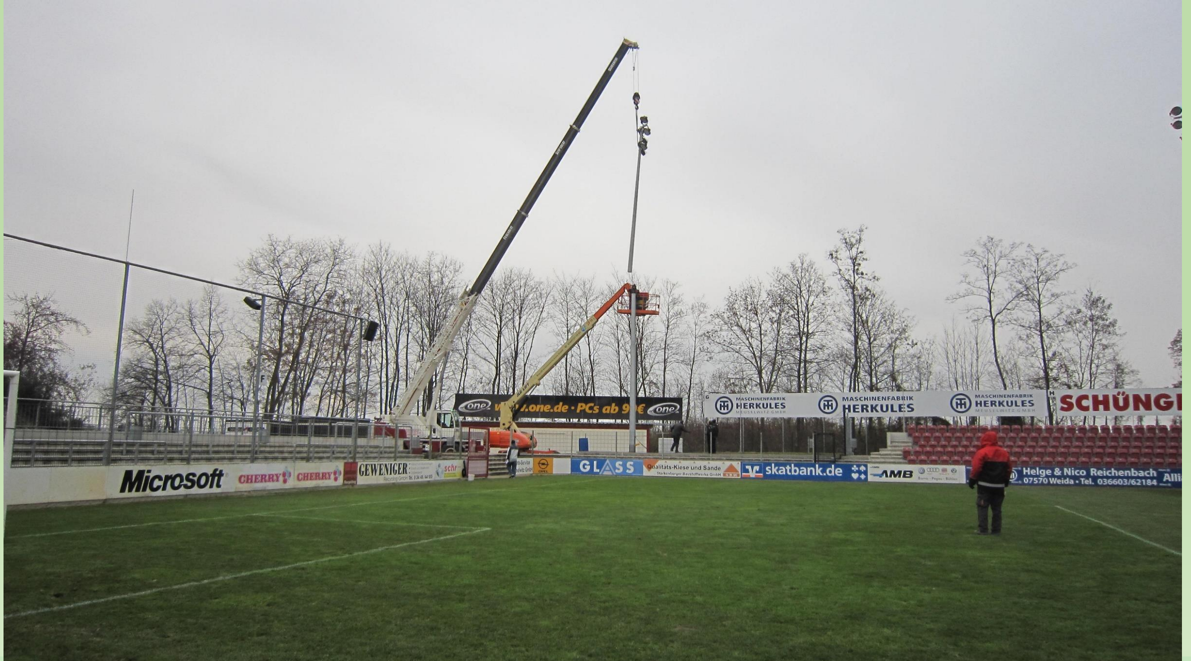
Windböen erschweren die Montage.
