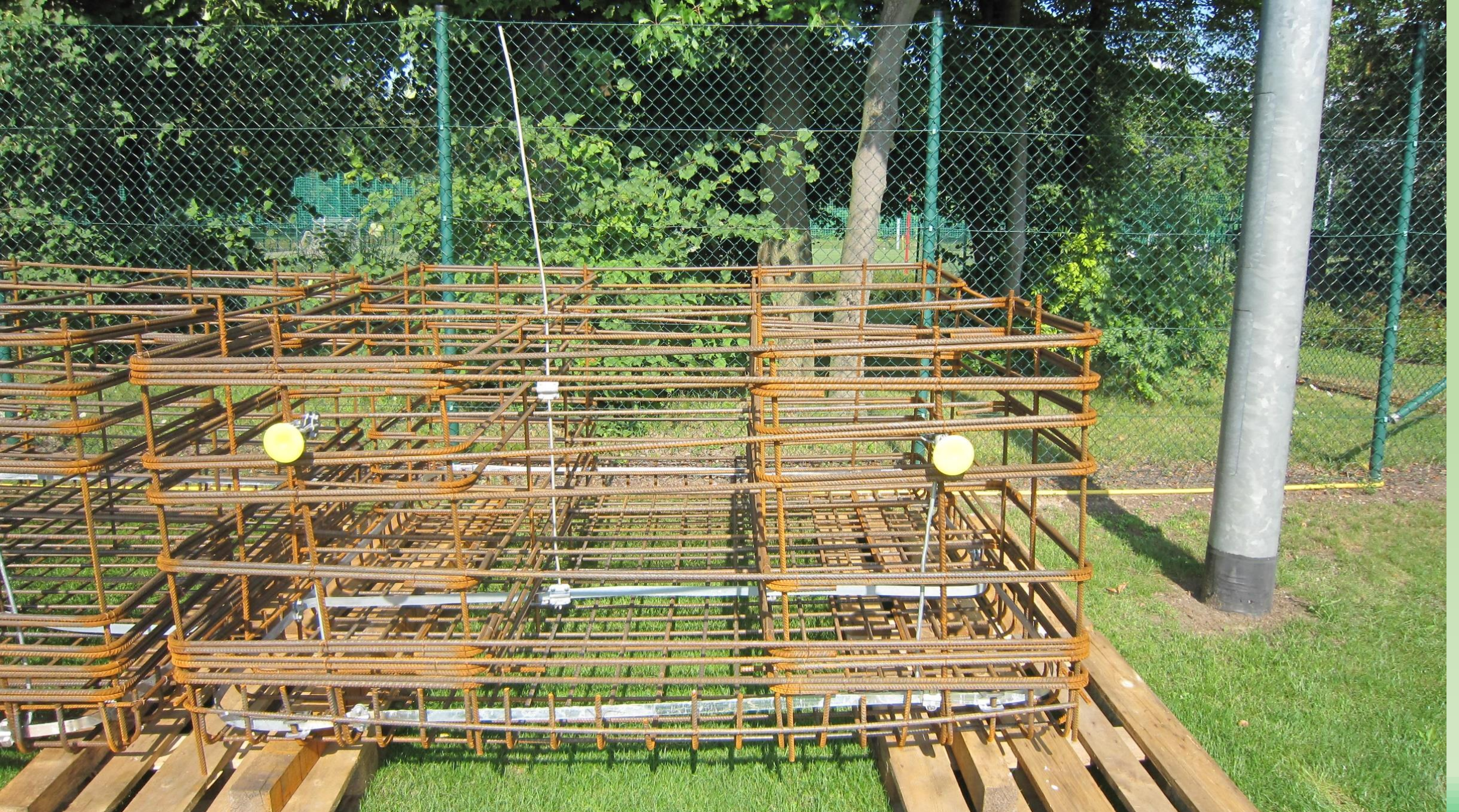
Der Blitzschutz ist eingeflochten.
