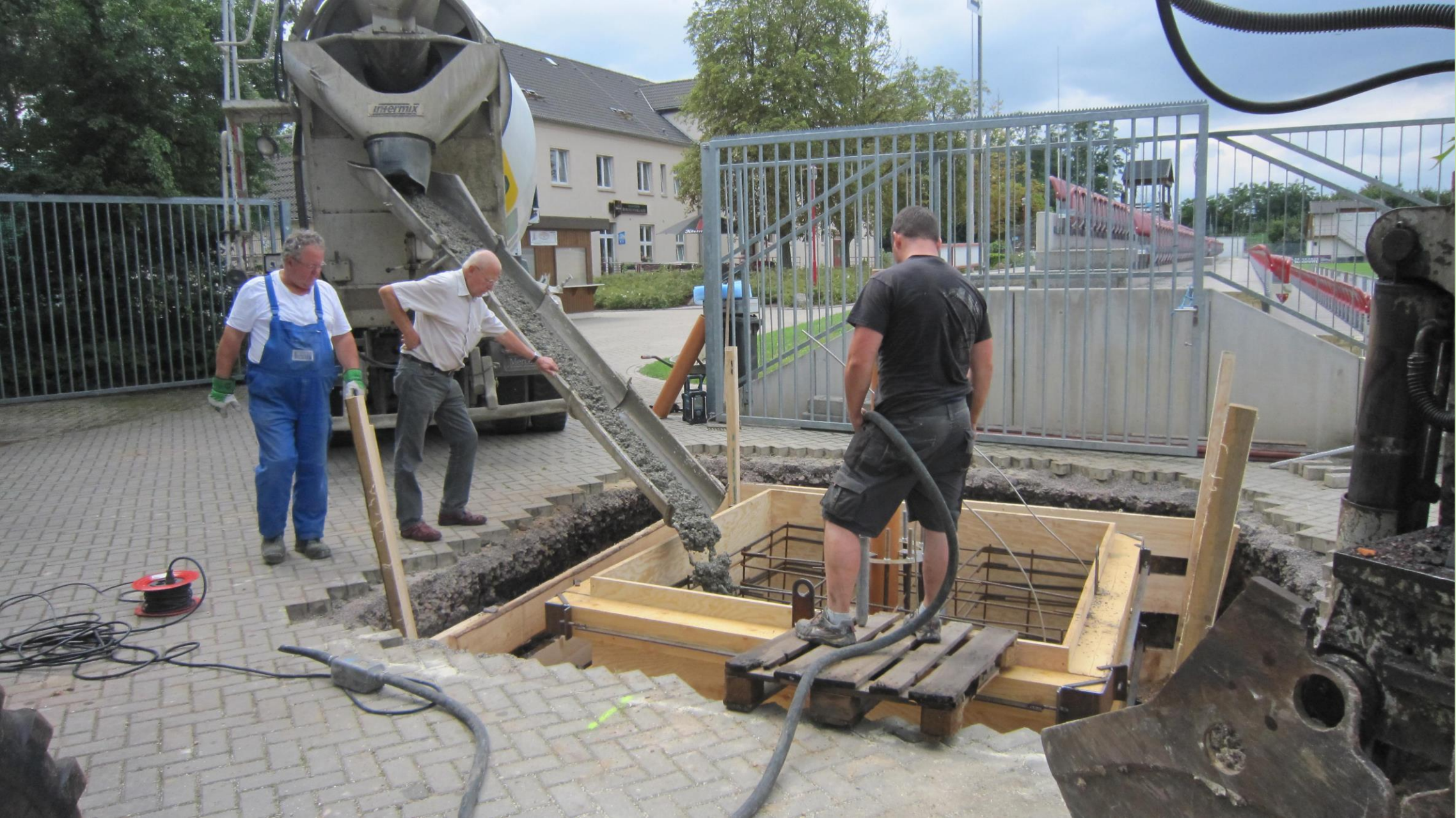
Der erste Beton fließt. Weitere 7 Fundamente folgen. Gewicht: je 14Tonnen. Größe: 2,20m x 2,20m x 1,20m (LBH)
