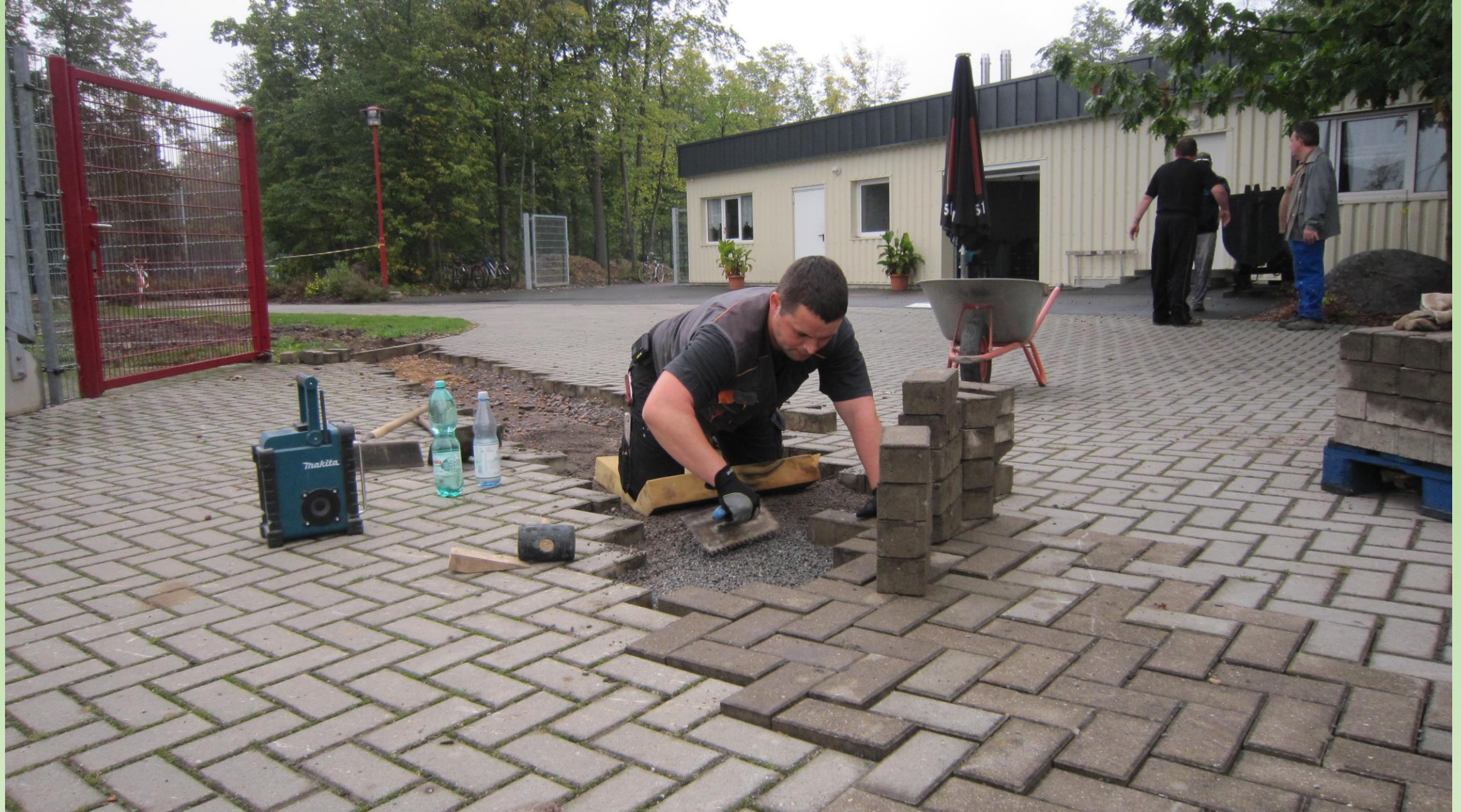
Pflasterarbeiten an den überbaggerten Wegen und Plätzen.
