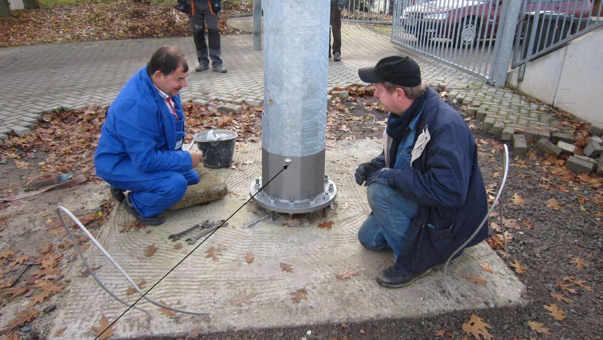
Ausrichten mittels eines Lotes.
