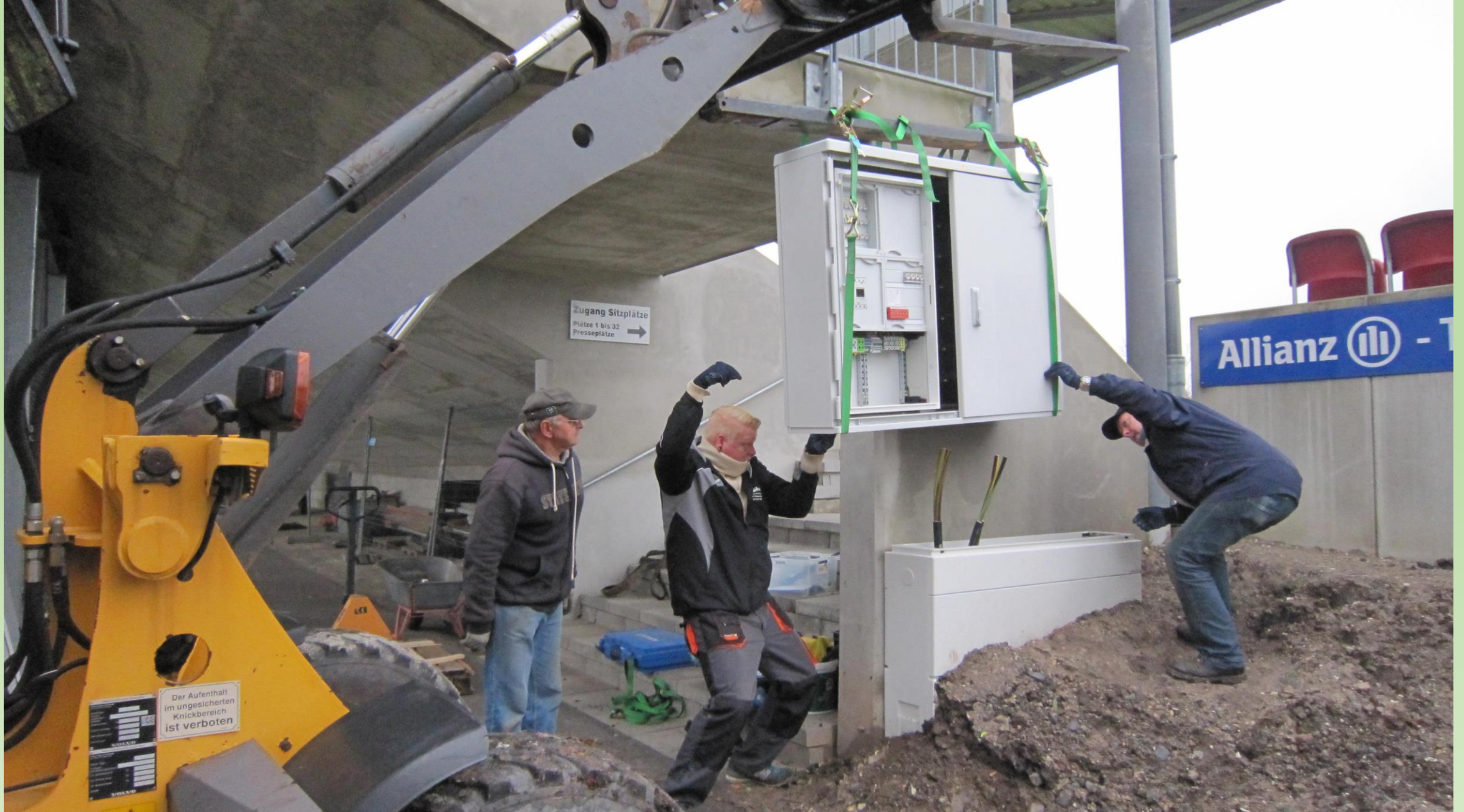
Ein Radlader hebt die über 250kg schweren Schaltschränke auf die Unterteile.
