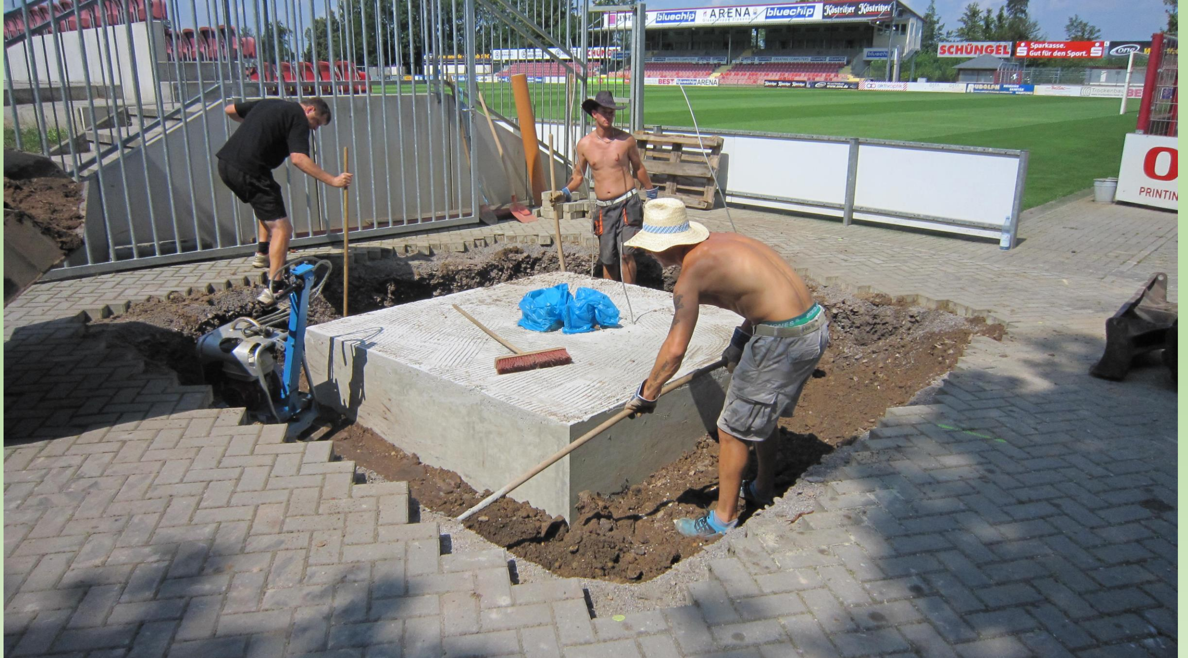
Nach dem Entfernen der Verschalung und der Baugrubenabsicherung erfolgt die Rückverfüllung der Baugrube.
