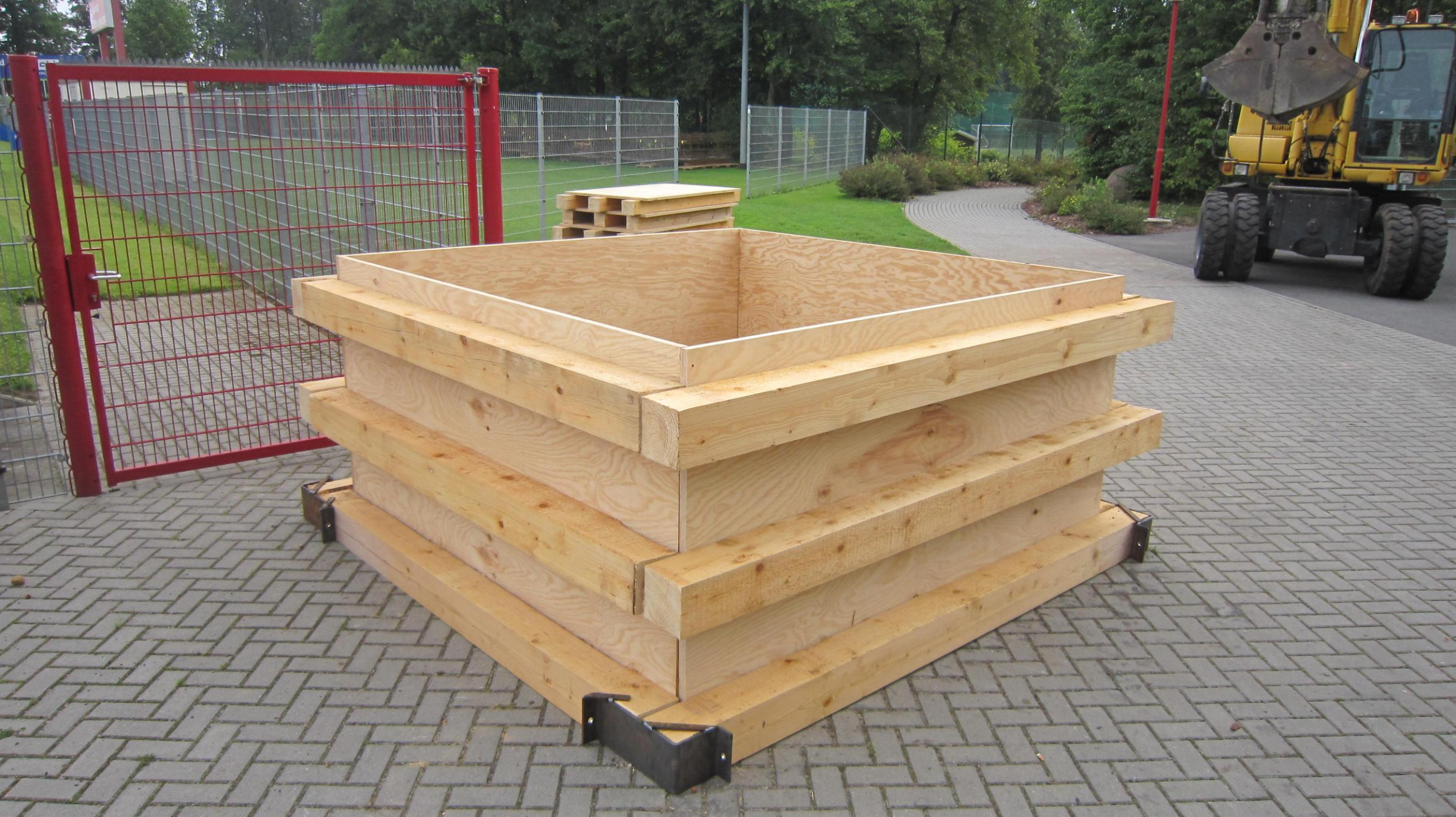
Die Verschalung für das Fundament. (Hier noch nicht fertig)
