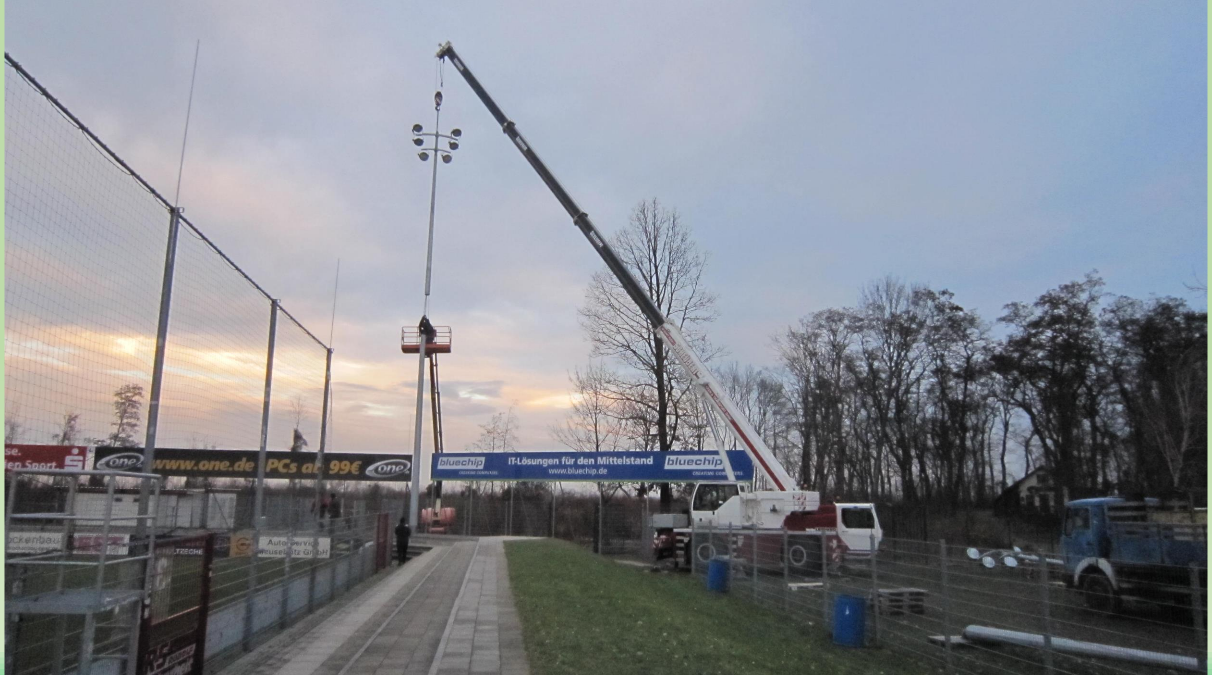
Montage der Mastoberteile.
