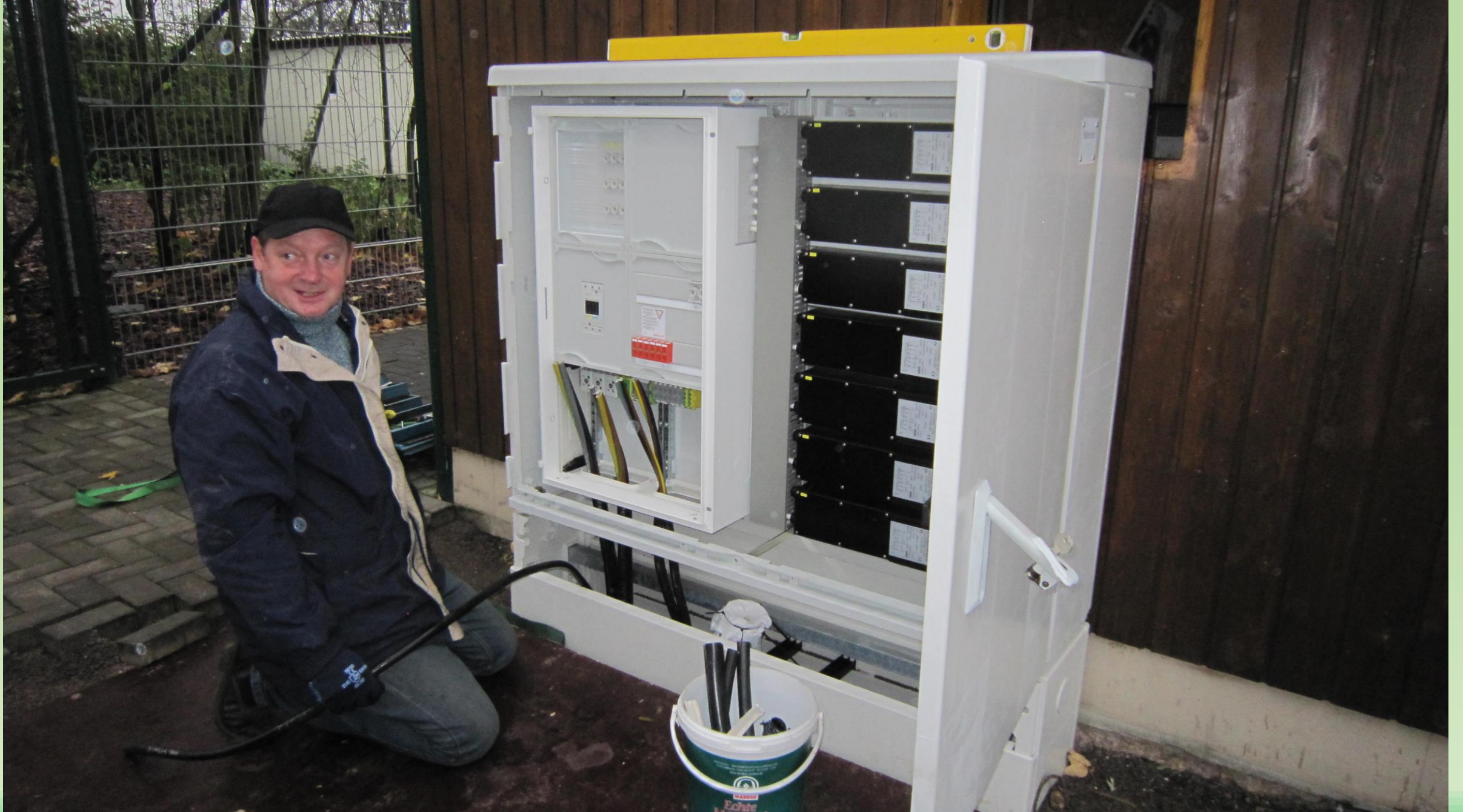
Einführen und Verschalten der Kabel. Rechts die Vorschaltgeräte mit einem Gewicht von je 30Kg.
