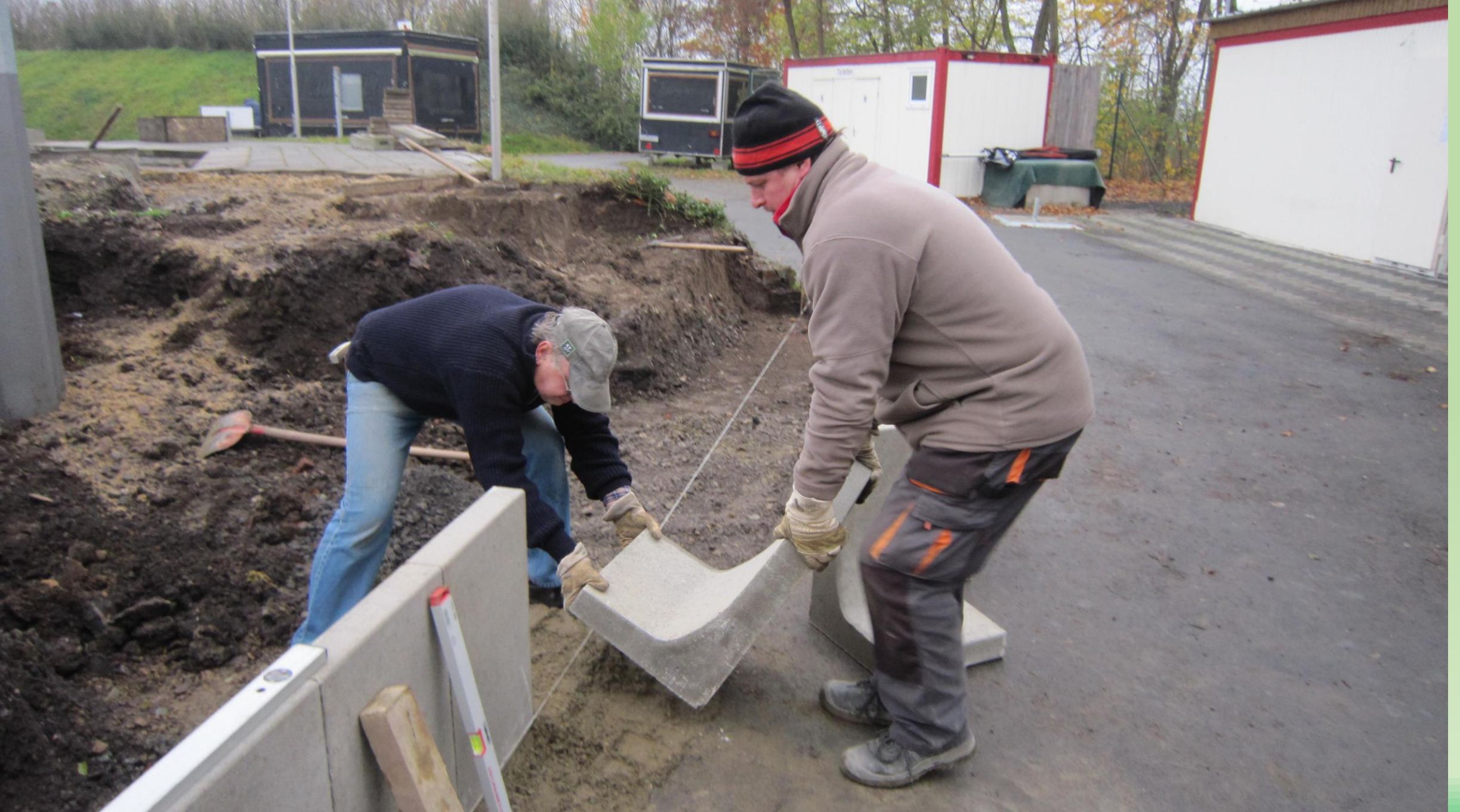
Der durch die Schachtarbeiten zerstörte Hang im Bereich der Fanbaude wird neu gestaltet.
