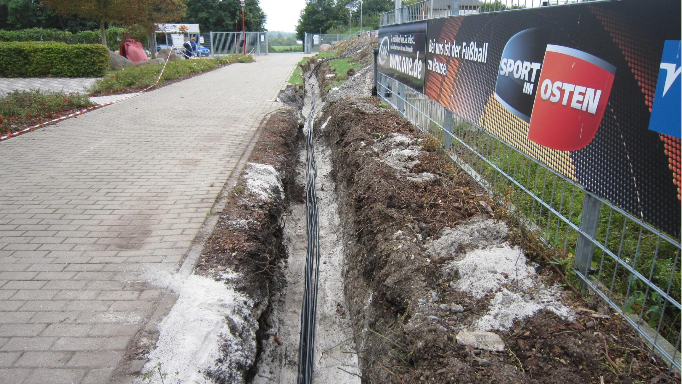
Zu jedem Mast führen mehrere Kabel.
