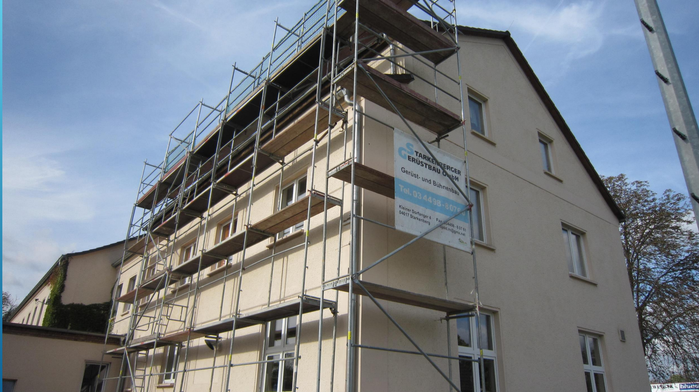
Begonnen wurde mit dem Einrüsten des Hauses.
