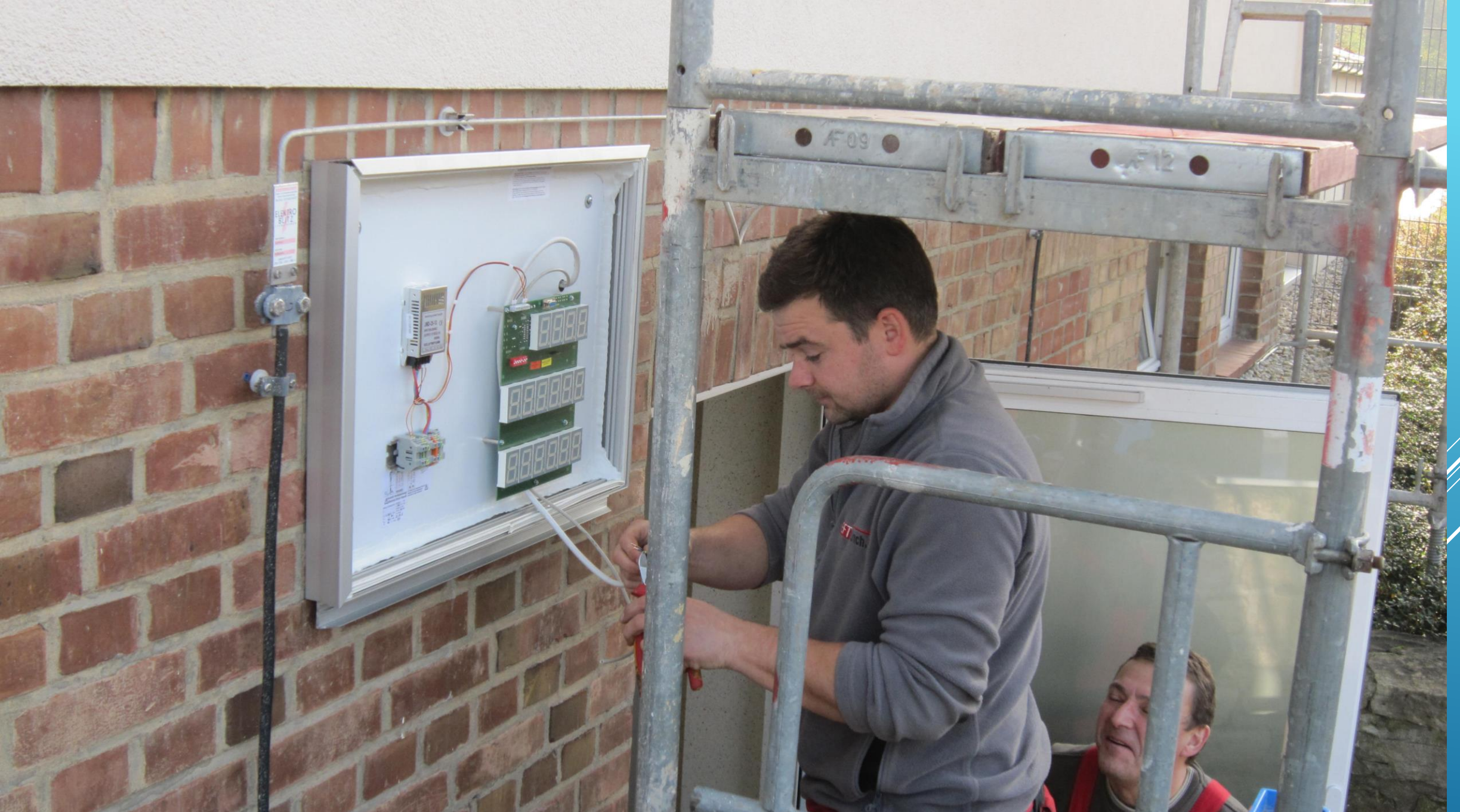
Am Eingang des Vereinsgebäudes wird ein Großdisplay angebracht.
