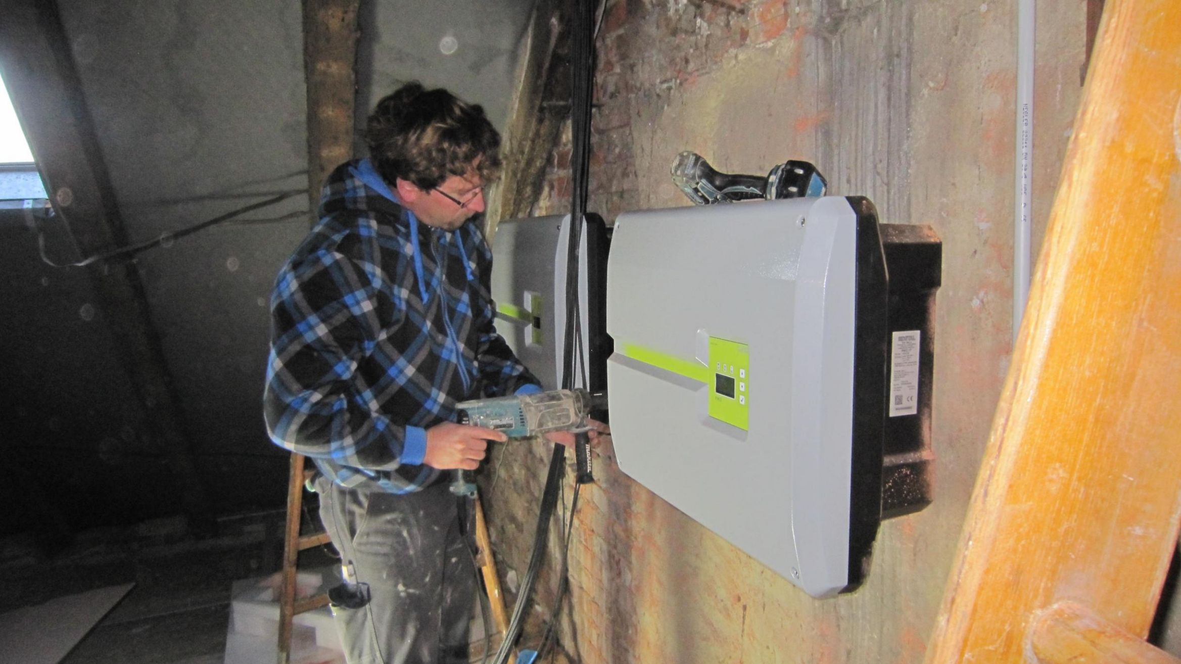
Die beiden Solarwechselrichter (KOSTAL PIKO 17) werden angebracht.
