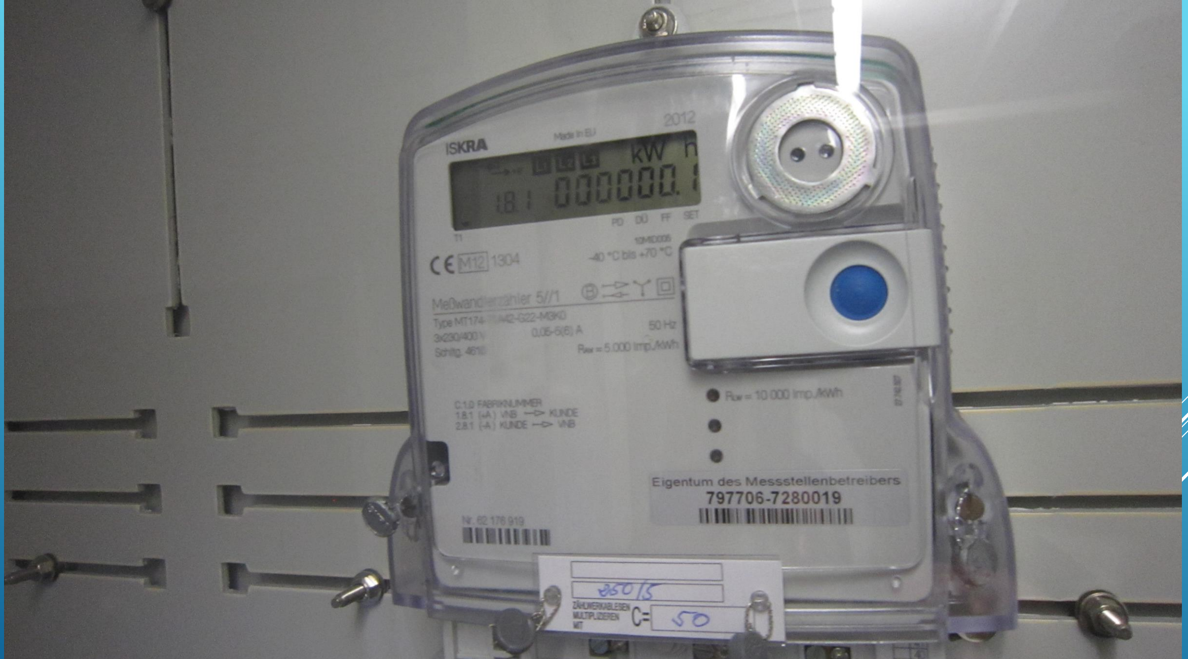
Ein spezieller Zähler zählt die entnommene und erzeugte Elektroenergie aus bzw. in das Netz.
